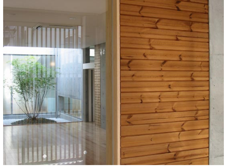
Seinä lämpökäsiteltyä mäntyä
